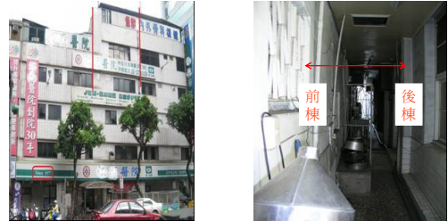
醫院之連棟建築物相互打通情形
