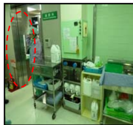
平時保持常開 火災時斷電無法自動關閉
