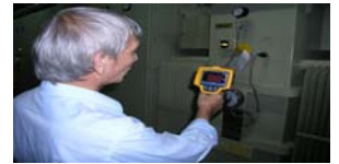
紅外線雷射檢測高耗電設備
