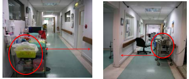
避難通道停放儀器及清潔推車致使疏散動線寬度不足
