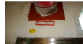
管線貫穿防火區劃處以防火泥填塞
